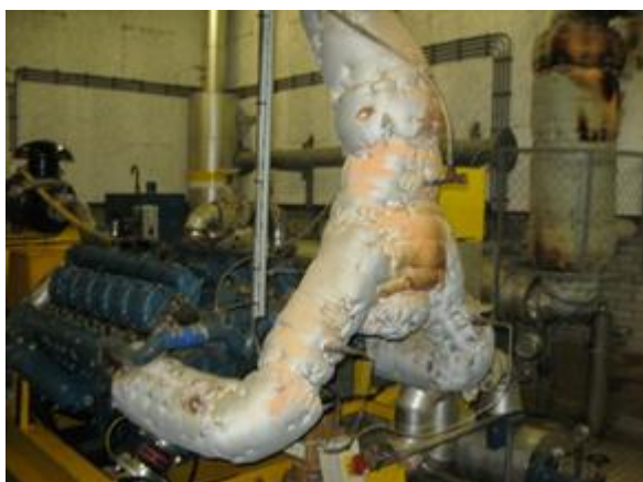
Rysunek 57. Spaliny jako źródło ciepła (silnik na biogaz)
